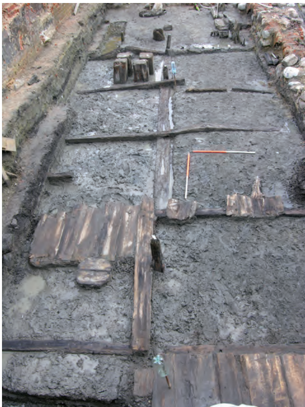
Ryc. 1. Konstrukcja podłogi chaty drewnianej z XIV/XVw. wraz z zachowanymi legarami i deskowaniem podłogi. Parcela Szeroka 91, widok od N. Foto z archiwum MAG
