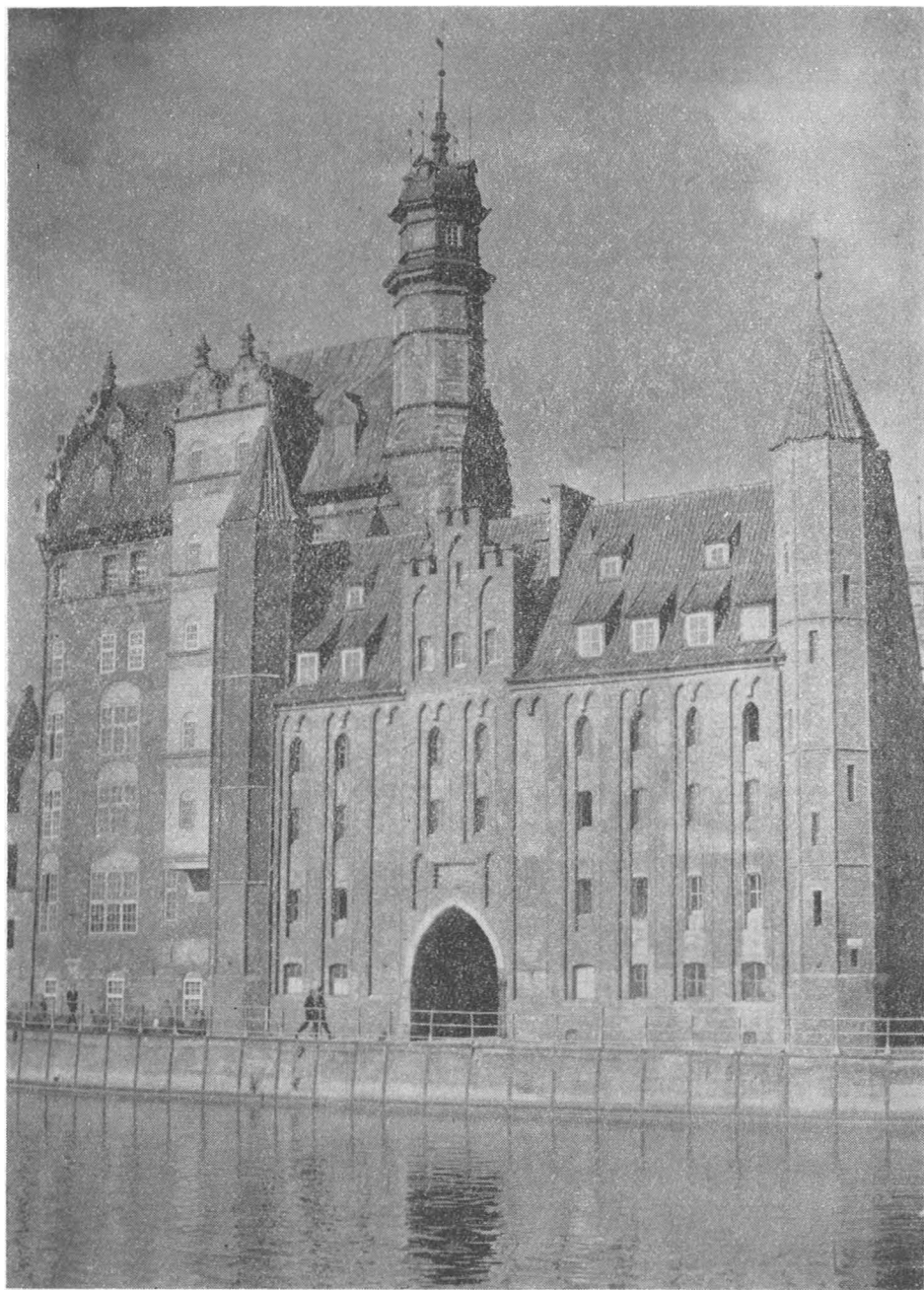
Ryc. 2. Gdańsk. Dom Przyrodników i Brama Mariacka po odbudowie Fig. 2. Gdańsk. The Naturalists' House and Mariacka Gate after rebuilding
